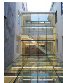
Innenhof und Treppenhaus werden verglast (2003).
